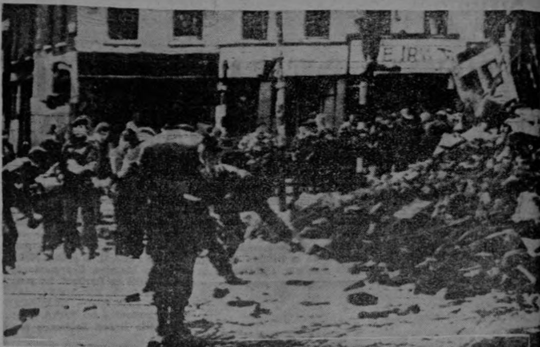
LIMPIAN ESCOMBROS. Belfast. — Soldados del regimiento de paracaidistas trabajan para limpiar escombros de una carretera en Belfast después que una bomba terrorista
